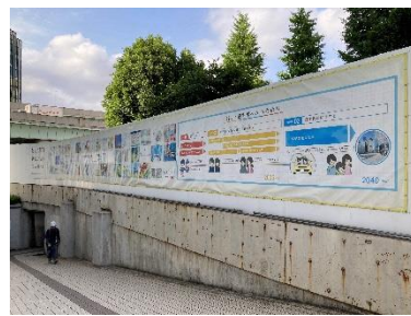
仮囲いの活用②(現地写真)
