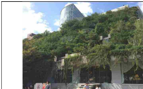
大規模公民複合施設においてトイレの洗浄水や植栽散水に利用している事例。（アクロス福岡） 出典1
