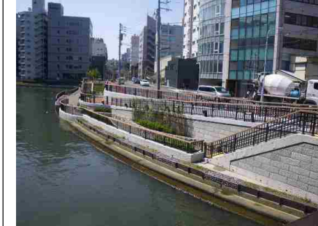
階段テラスとスロープの設置
