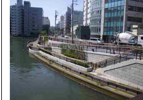
階段テラスとスロープの設置
