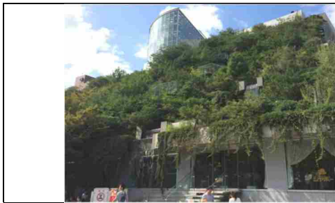
大規模公民複合施設においてトイレの洗浄水や植栽散水に利用している事例（アクロス福岡） 出典1
