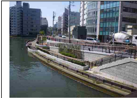
階段テラスとスロープの設置
