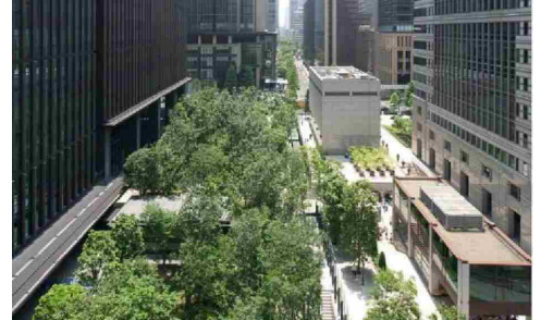
オフィス街に森を再現しビジネス空間に自然環境を提供している事例（大手町の森／千代田区） 出典1
