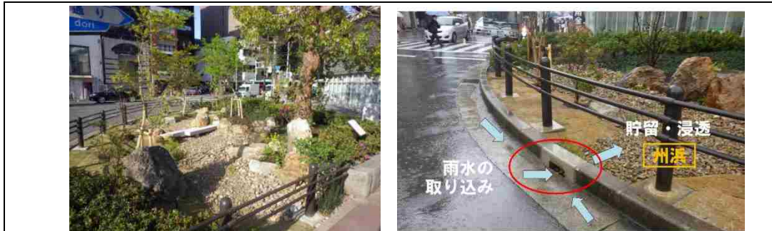
庭園風に整備されたレインガーデン（雨庭）。雨水の取り込み口を設け、舗装面からも集水している。（四条堀川交差点/京都市） 出典4
