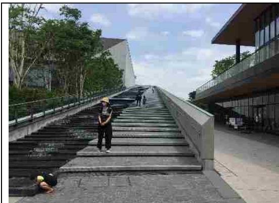
全長 120mある階段状のカスケードで、水と緑の景観を形成しつつ親水空間にもなっている事例 (立川グリーンスプリングス/立川市)
