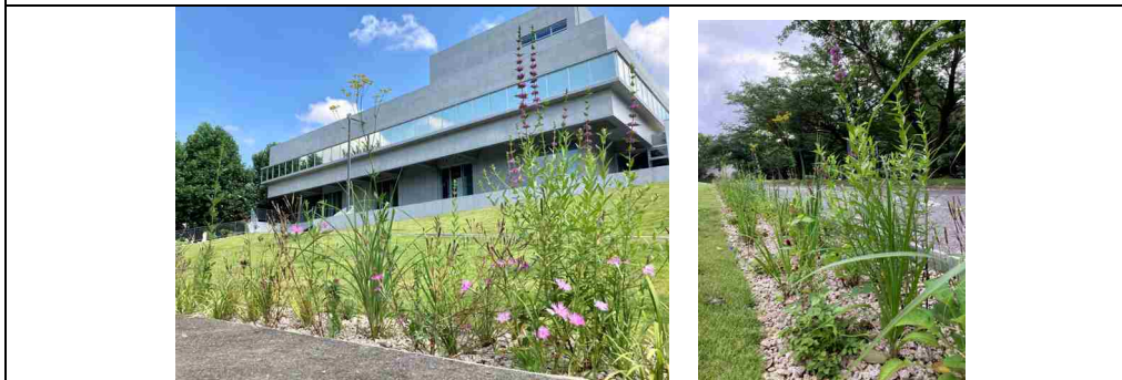
建物の屋根に降った雨を植栽帯に集め、貯留し、地中へ浸透させている。植栽には在来種を選定している。（千葉大学園芸学部／松戸市）
