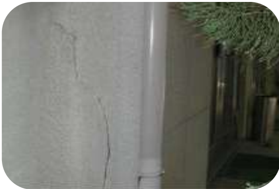
外壁塗り仕上
