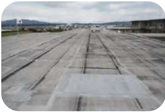
アスファルト露出防水
