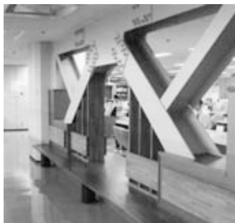
耐震補強工事例
