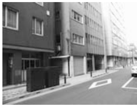
電線類の地中化（施工後）
