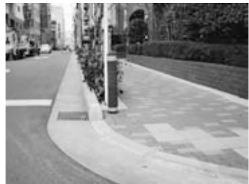
歩道のセミフラット化
