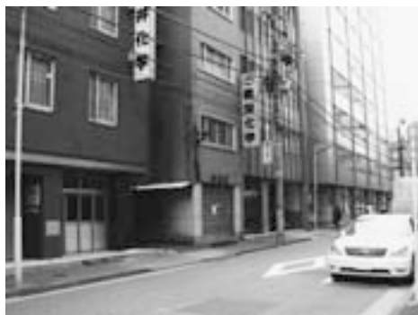
電線類の地中化（施工前）
