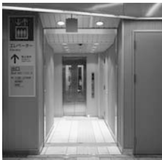
エレベーター整備（京葉線八丁堀駅）
