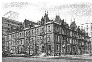
写真3 三菱一号館（解体前：(株)三菱地所設計提供）
