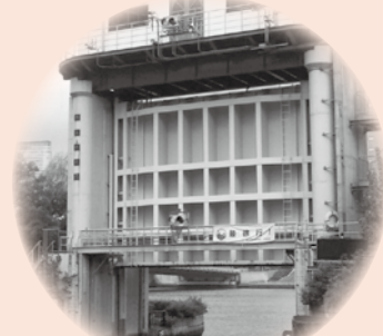
月島水門。水門は、高潮時には堤防の 役割をします (事業スタッフ 中原撮影)
