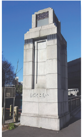
▲一石橋の親柱 都内最古のRCアーチ橋の親柱として今もなお堂々たる姿を見せています。中央区総括文化財調査指導員 増山一成
