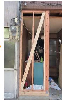
④柱を新設し、筋交いを設置します。
