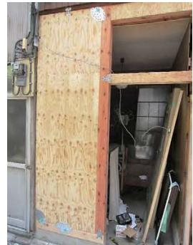
⑤構造用合板を設置し、接合部を金物で補強します。
