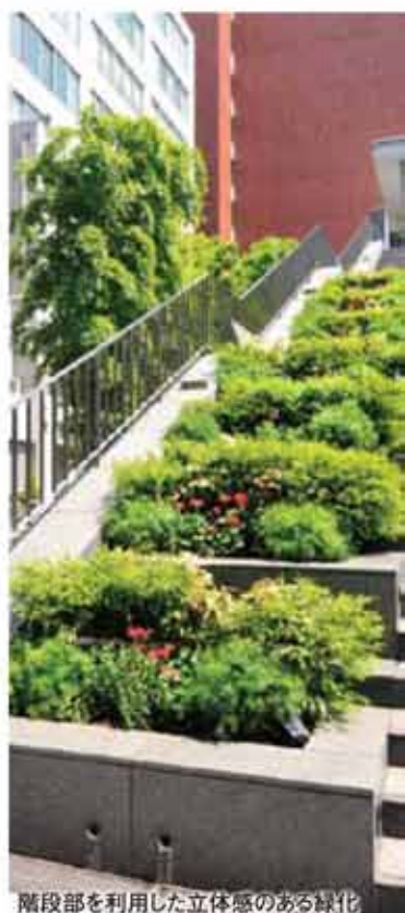
階段部を利用した立体感のある緑化
