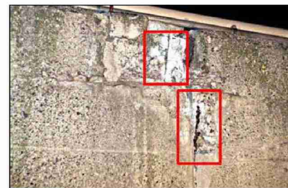
コンクリートの剥離・鉄筋腐食
