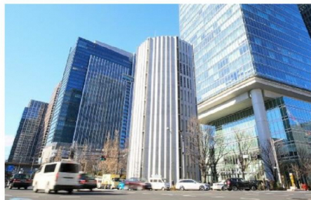
現在の鍛冶橋換気塔
