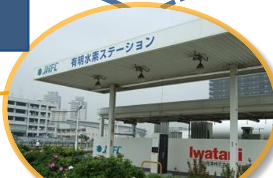
水素ステーション
