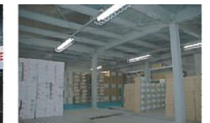
地域備蓄倉庫
