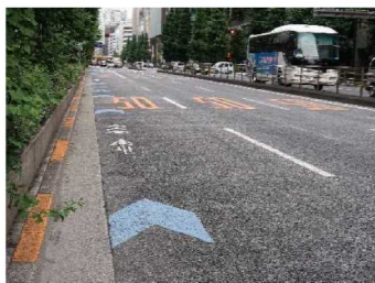
車道混在 (自転車ナビマーク・ナビライン) 鍛冶橋通り(中央区)
