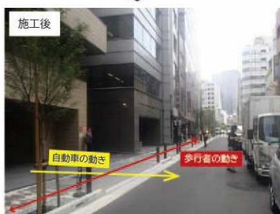
施工後 セミフラット方式の歩道（計画） 車道と歩道をおおむね同じ高さにするこで、車両乗り入れ部分で歩道の上下の変動を小さくする。
