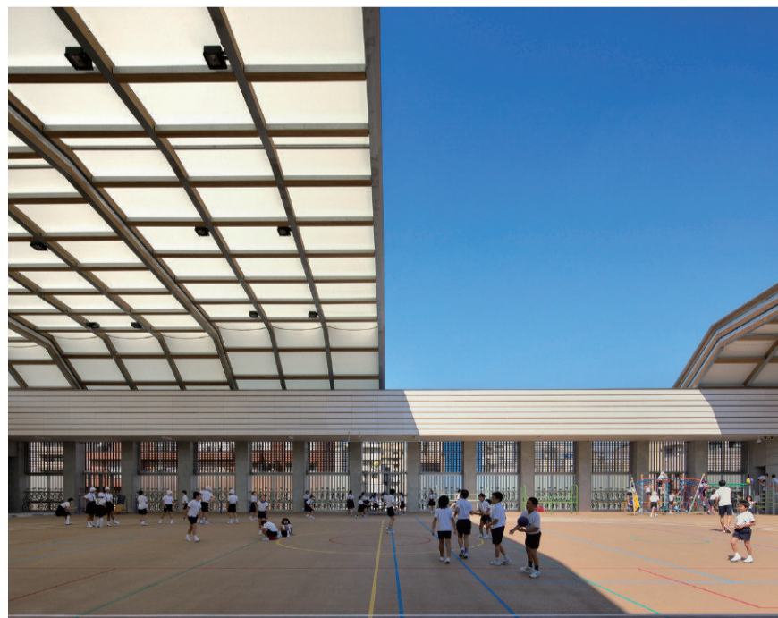
▲区立中央小学校屋上校庭
