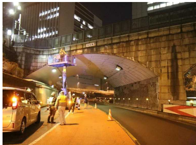
高所作業車による点検
