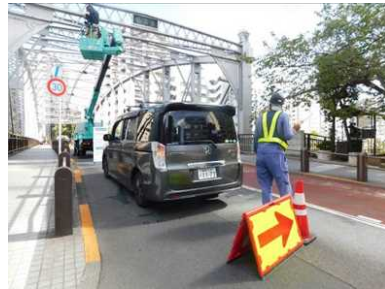
高所作業車による点検
