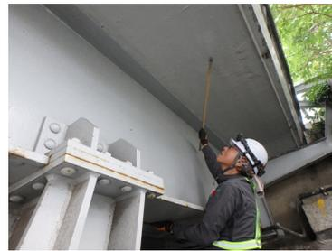
コンクリート剥離箇所の叩き落とし
