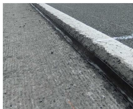
写真- 4.1 L型止水テープの施工
