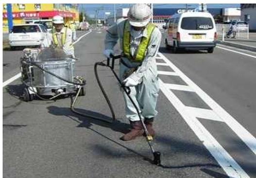
写真- 3.7 クラックシール材注入工法
