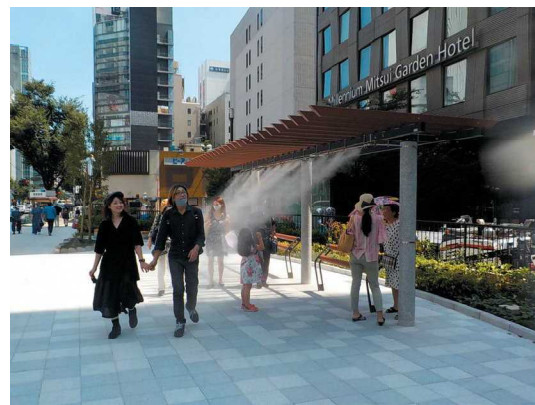
ミスト設備による暑熱対策 (三原橋街角広場／中央区)
