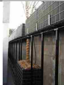
護岸裏のメッシュプランター、と支持用単管パイプ、高木用プランター
