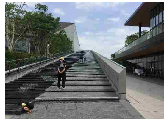
全長 120mある階段状のカスケードで、水と緑の景観を形成しつつ親水空間にもなっている事例 (立川グリーンズプリングス/立川市)
