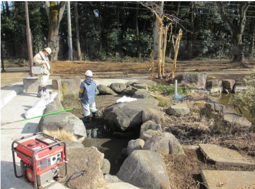
⑦池の水抜き作業
