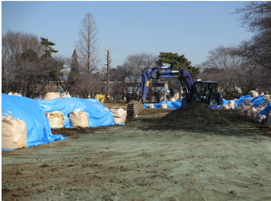
③グラウンド(トラック)でのすき取り作業
