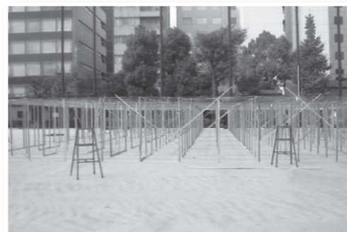
▲柱を立てて布を貼る前の、迷路の骨組みの様子。貴重な写真です。
