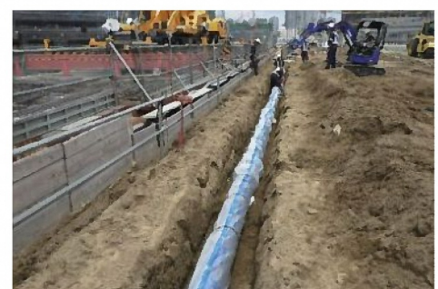
埋設物の設置状況 (平成 30 年 8 月)
