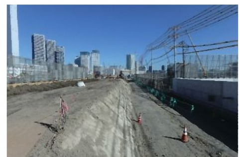
盛土工事の状況 (平成 29 年 11 月)
