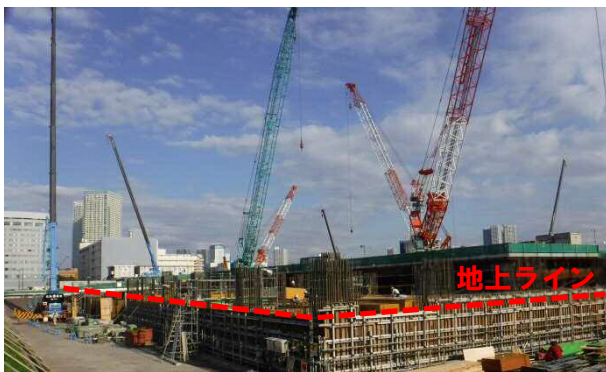
建築躯体の整備状況（5-3街区）
