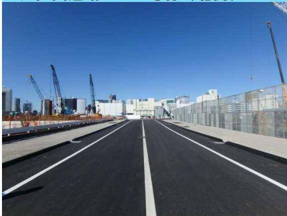
道路の仮舗装が完了しました。
