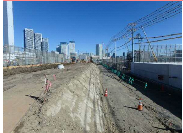
道路断面の半分の もりど 盛土を行っています。
