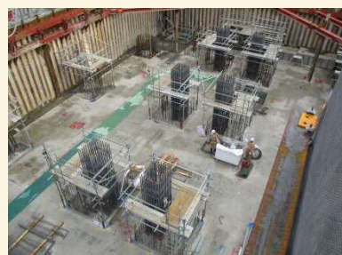
所定の箇所への設置
