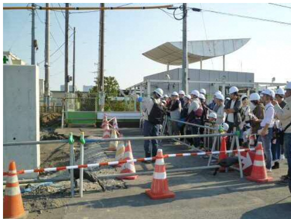
防潮堤の整備状況について説明
