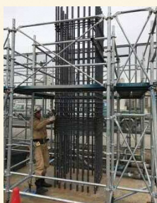
地上での鉄筋組立て
