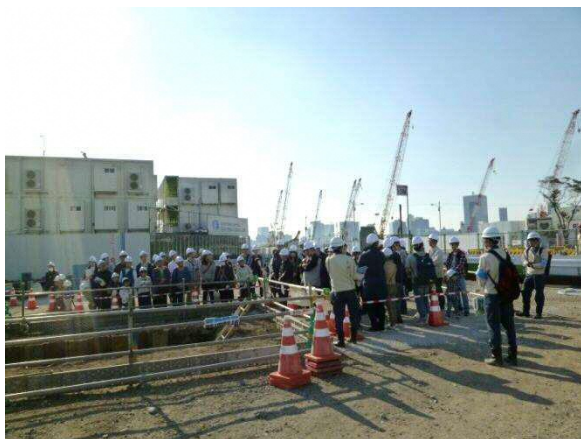
下水道の布設状況について説明
