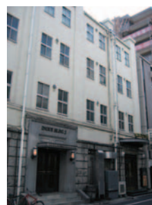
旧ビルの活用 昭和初期等に建てられた魅力的な旧ビル等を活用して、飲食店や古本屋などがオープンしている。
