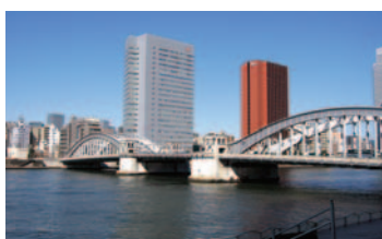
勝鬨橋 昭和15年(1940)に建設された日本でも珍しい跳ね橋。当初は1日5回跳開していたが、昭和45年(1970)を最後に跳開していない。
