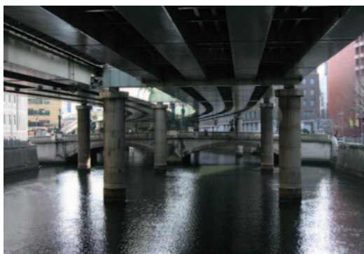
日本橋上空の首都高速 昭和39年(1964)の東京オリンピックを控え、日本橋の直上に首都高速道路が建設されたが、地域を中心としてその景観を再生したいという動きが高まっている。
