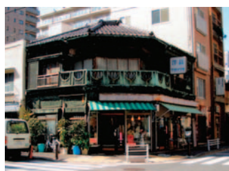
看板建築 正面に銅板を貼りつけて装飾している看板建築は、まちの歴史を感じさせ、新鮮なインパクトを持ちまちに風格を与えている。
