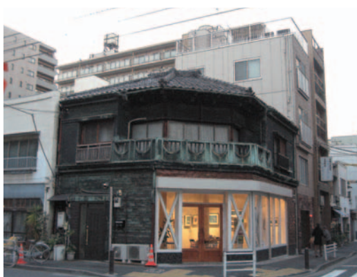
看板建築の画廊 時代を感じさせる銅版貼りの建築をうまく活かしながら画廊に改修し、地域の文化スポットになっている。
