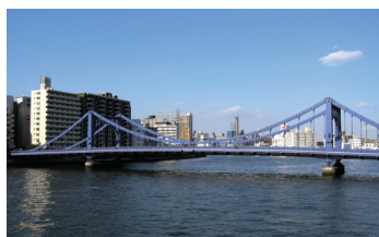
清洲橋 昭和3年(1928)にドイツケルン市の吊り橋をモデルに造られた橋であり、隅田川の架橋の中でも一番美しいと言われている。
