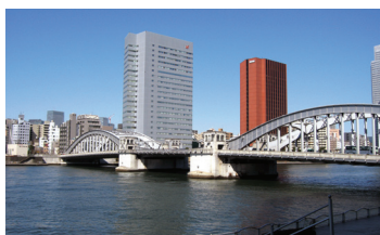
勝鬨橋 昭和15年(1940)に建設された日本でも珍しい跳ね橋。当初は1日5回跳開していたが、昭和45年(1970)を最後に跳開していない。
