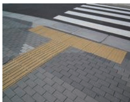
点字ブロック（点字ブロック）
