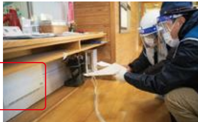
【Wi-Fi 設備の確認】
