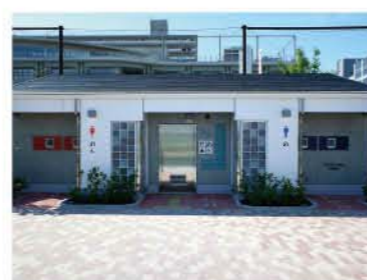
豊海運動公園内公衆便所
