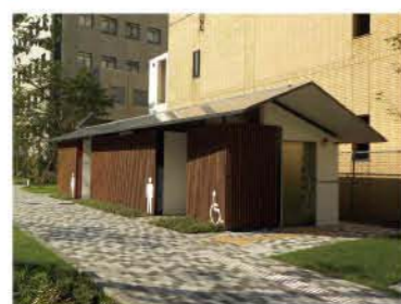
坂本町公園内公衆便所
