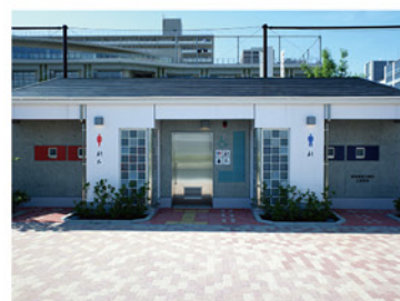
豊海運動公園内公衆便所
