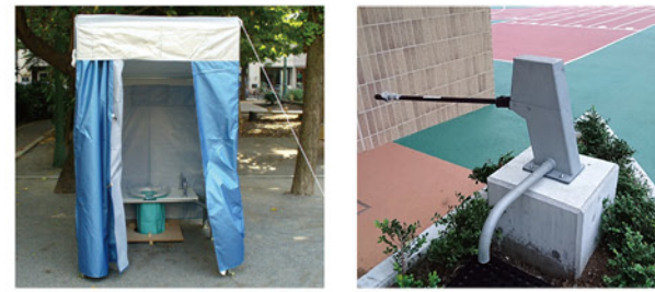
マンホールトイレ 防災用井戸
