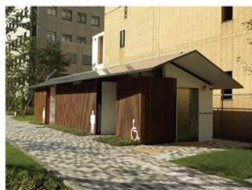
坂本町公園内公衆便所
