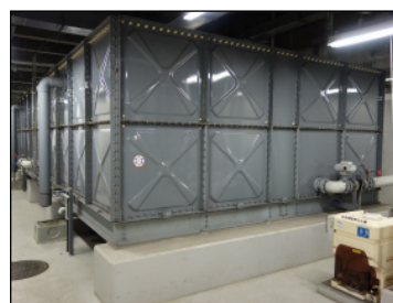
受水槽(地下2階住宅用受水槽ポンプ室)
