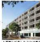
▲沿道に張り出した立体駐車場
