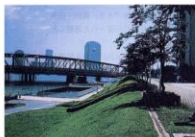
▲護岸沿いの親水緑地の事例
