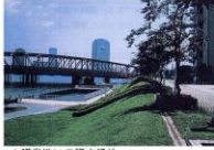
▲護岸沿いの親水緑地の事例
