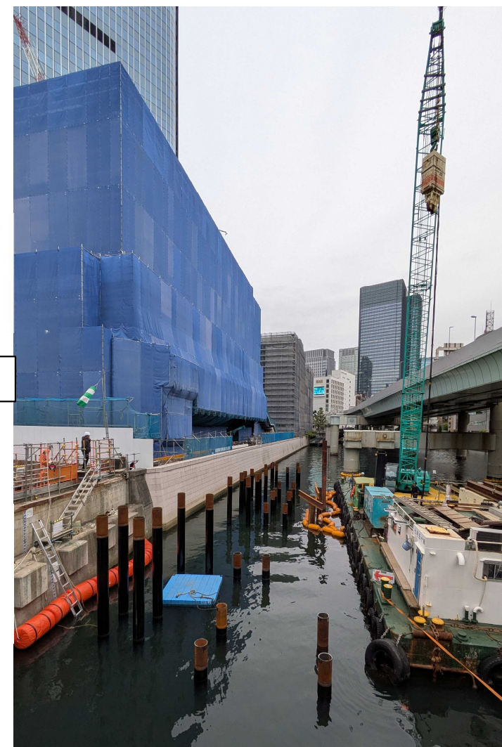
写真1 船着場棧橋杭 打設状況
