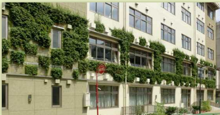
(壁面緑化) 久松小学校・久松幼稚園
