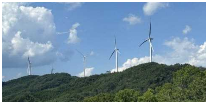
阿武隈風力発電所の風力発電設備(阿武隈風力発電所 撮影)
