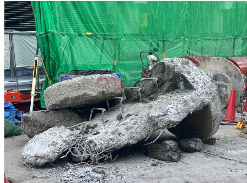
写真2 撤去状況（既設地下躯体）
