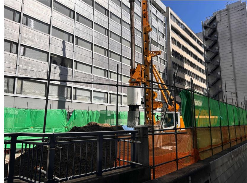
写真1 施工状況（支障物撤去工）
