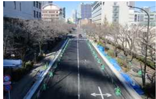
▲工事現場（令和7年2月現在）
