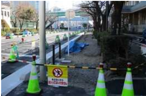
▲歩道拡幅・自転車通行帯整備箇所
