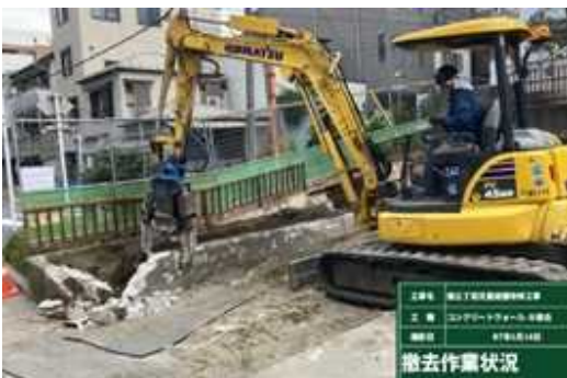
▲コンクリートウォール撤去工事
