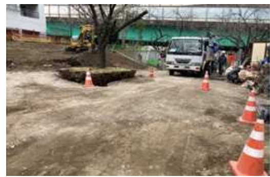
▲敷地造成工事
