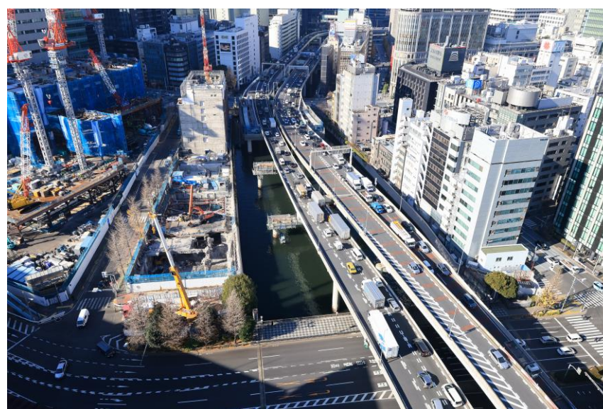
橋けた・橋脚撤去状況（江戸橋入口）
