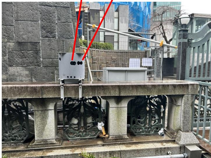
写真 計測用機械（滝の広場）
