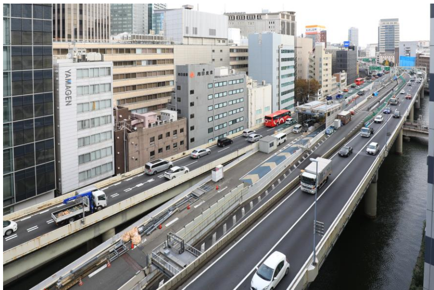
橋けた撤去前
