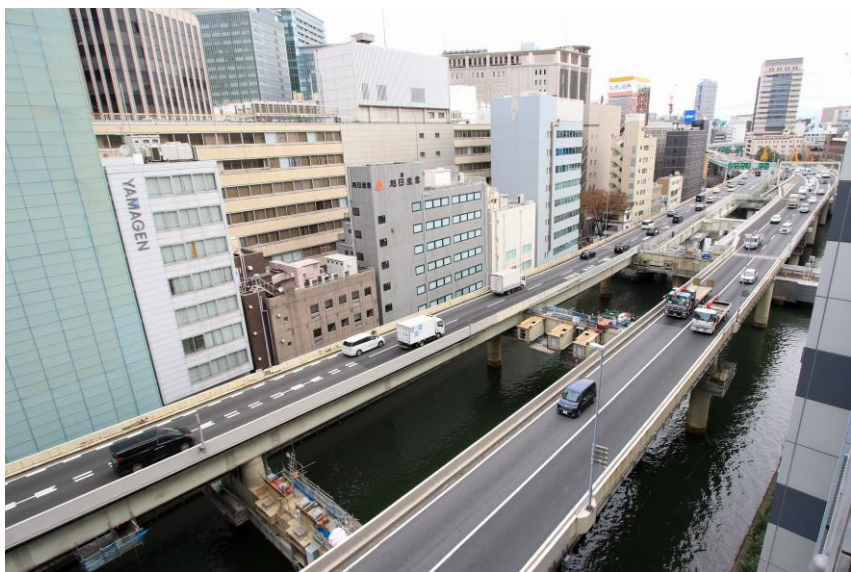
橋けた撤去後（呉服橋出入口）
