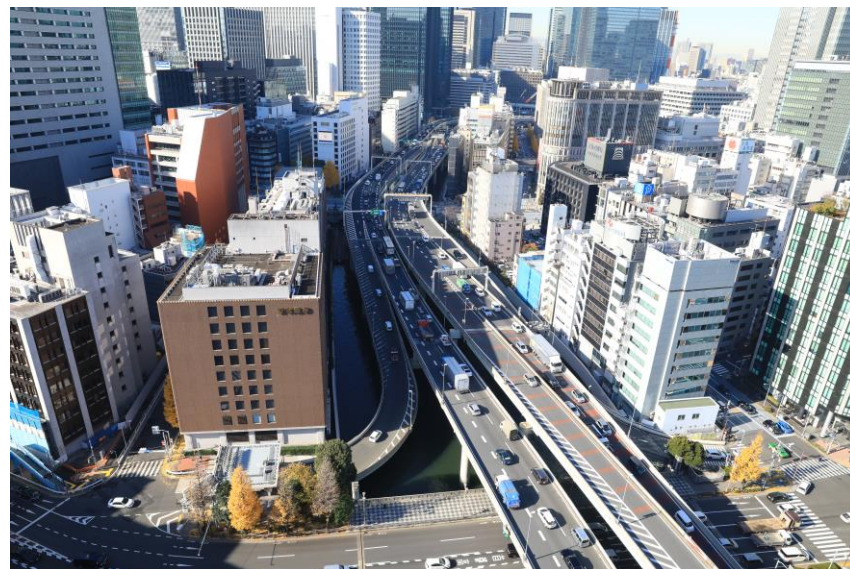
橋けた撤去前
