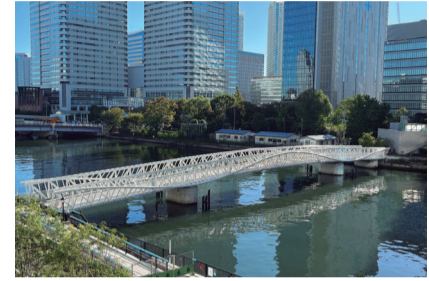
▲建設中の黎明小橋
