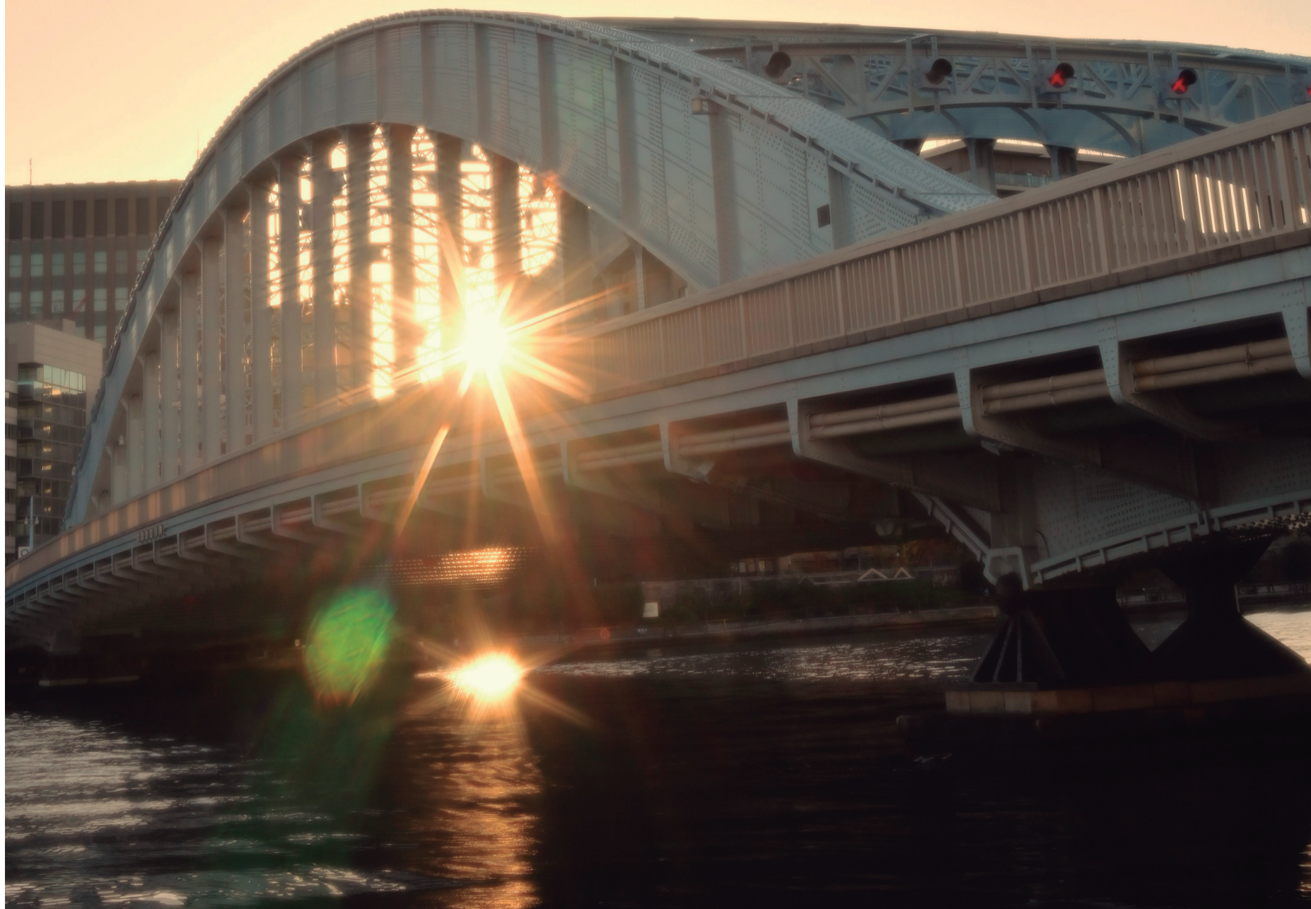
▲永代橋と朝日
