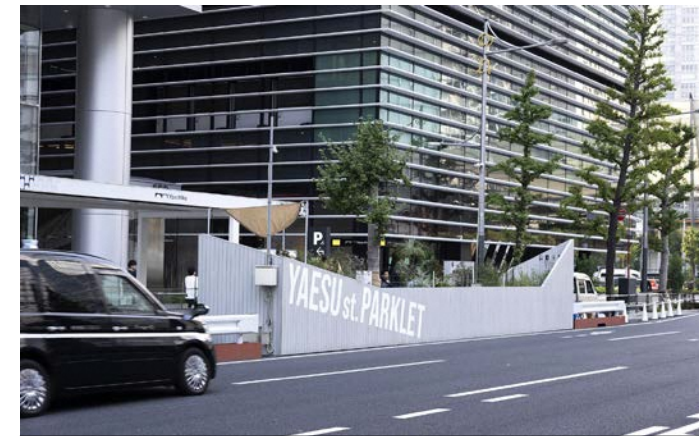
【パークレット全景（車道側）】
