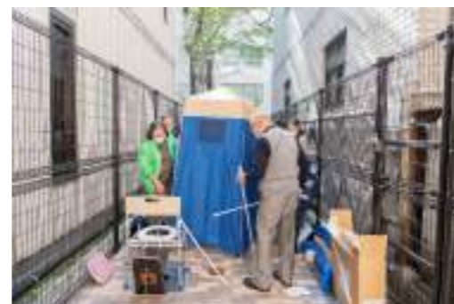
【マンホールトイレ】
