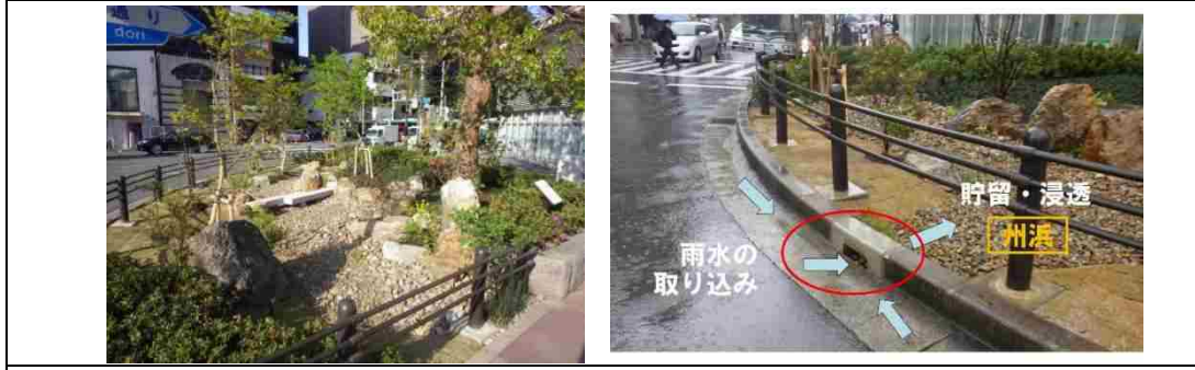
庭園風に整備されたレインガーデン（雨庭）。雨水の取り込み口を設け、舗装面からも集水している。（四条堀川交差点/京都市） 出典4
