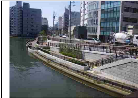
階段テラスとスロープの設置
