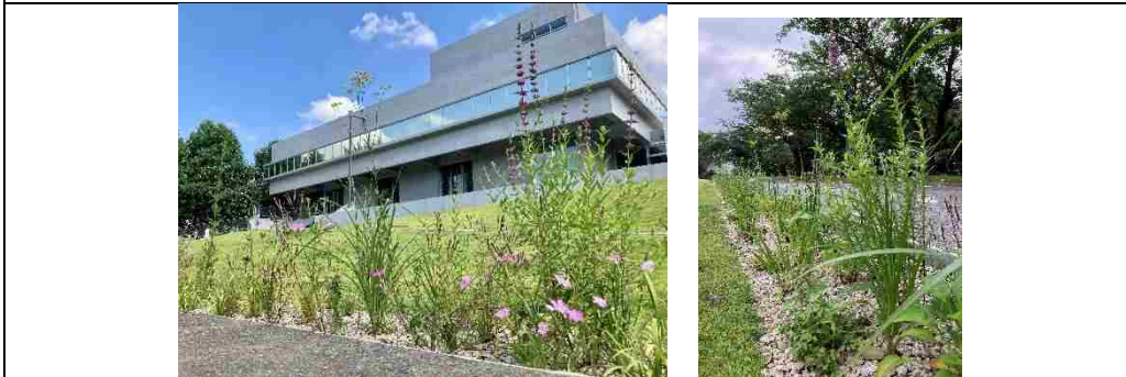
建物の屋根に降った雨を植栽帯に集め、貯留し、地中へ浸透させている。植栽には在来種を選定している。（千葉大学園芸学部／松戸市）
