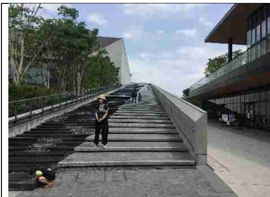
全長 120mある階段状のカスケードで、水と緑の景観を形成しつつ親水空間にもなっている事例 (立川グリーンズプリングス/立川市)
