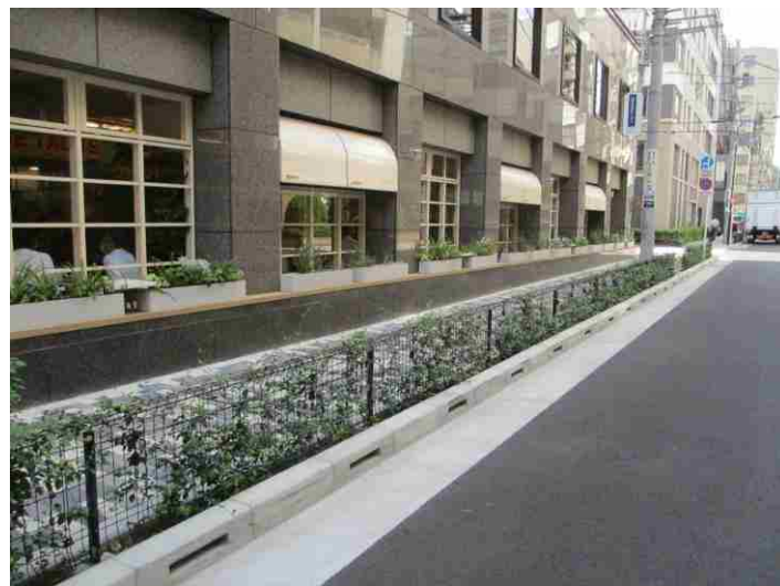
日本橋小伝馬町3先 緑化フェンス
