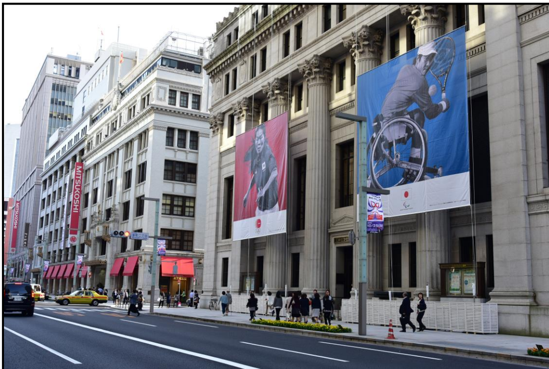
日本橋シティトレッシング
